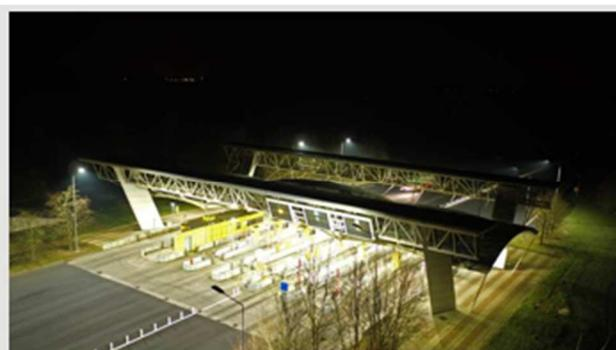
On obtient donc une équivalence 71 Lux SHP pour 44 Lux LED, soit une réduction du niveau d'éclairement de 38 %.
